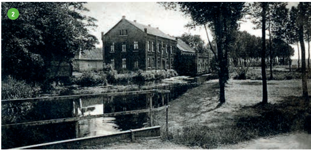
Oedter Burgmühle. Heute ist das alte Mühlengebäude ein Mehrfamilienhaus.
