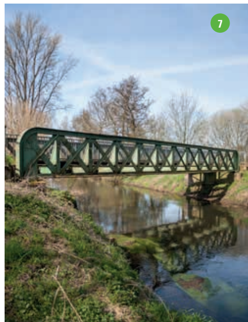
Ehem. Eisenbahnbrücke, Oedt-Süchteln
